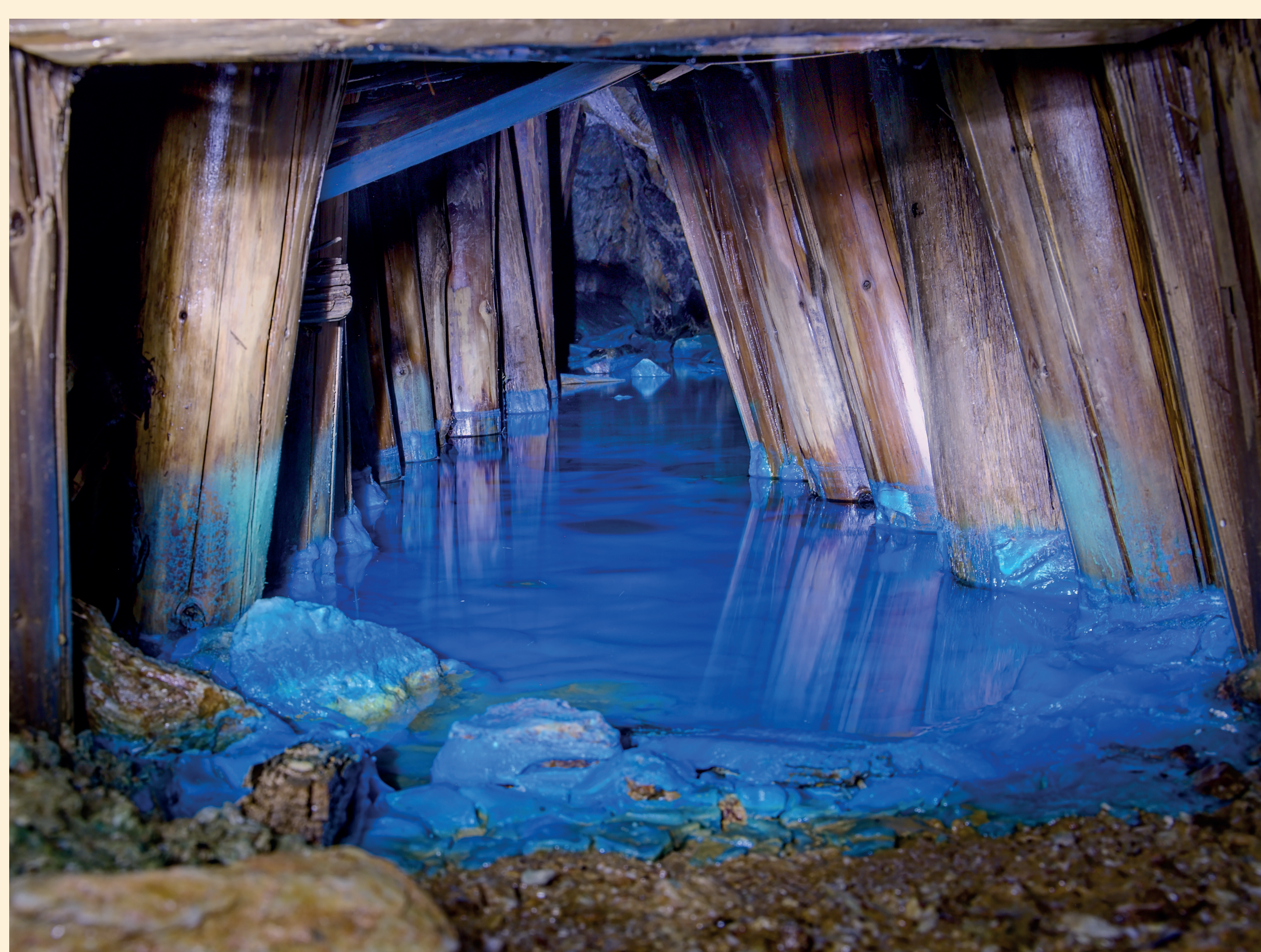
Uvodná časť štôlni Jacobi s mohutnou drevenou výstužou. Posledná fotografia z r. 2019 Foto: S. Kovačič
