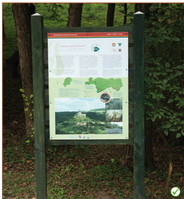
Na snímkach vpravo aj vľavo je príklad vhodne zvolenej náučno-informačnej tabule a panelu (pevná konštrukcia, ukotvenie, farba, svetlostálosť, informácie v 2 – 3 jazykoch, dobre čitateľné, s mapou).
