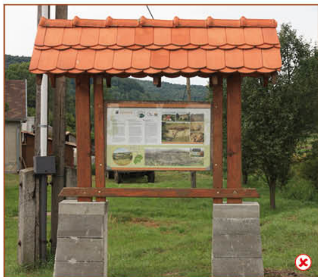
Ukážka použitia príliš veľkého množstva hmoty nosiča náučno-informačnej tabule, oproti pomerne malému panelu bez povrchovej úpravy pätiiek – obloženie kameňom, omietnutie
