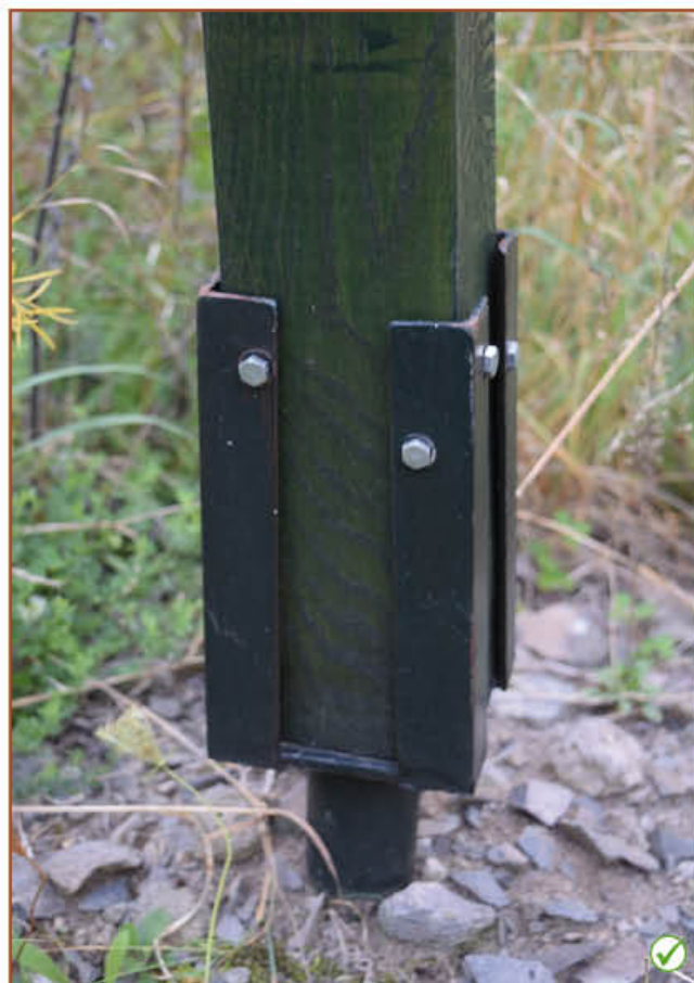
Príklad dobrého systému spojenia drevenej konštrukcie s betónovým lôžkom prostredníctvom kvalitnej oceľovej pätky, umožňujúceho ľahkú montáž a demontáž
