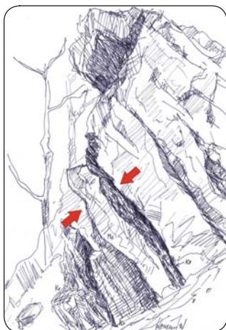
Obr. 6 Skalné bralo na svahu doliny Teplá vo vrchnej časti tvoria spodnotriasové kremence (Me), v spodnej časti silne zbridličnatené kryštalinikum (Kr) tvorené vyhnianskou drvenou žulou. Kontakt je indikovaný šípkami. Šupina kryštalinika je tektonicky zaškripaná medzi spodnotriasovými kremencami (horná šíпка). Pohľad na skalné bralo je od juhu na sever
